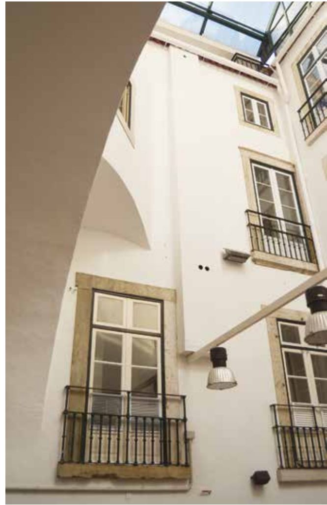
Fig. 7 - Remanescência da chaminé no pátio interior.
