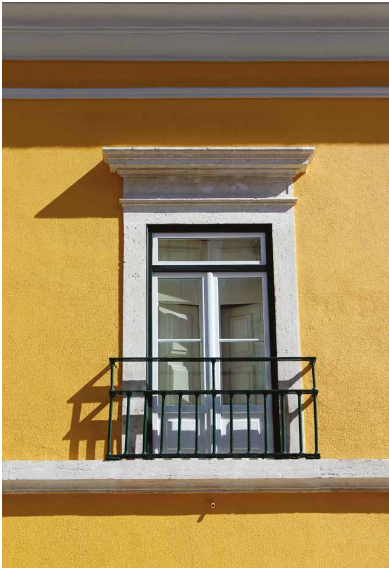
Fig. 2 – Janela de sacada do piso nobre (João Vieira Caldas, 2013).
