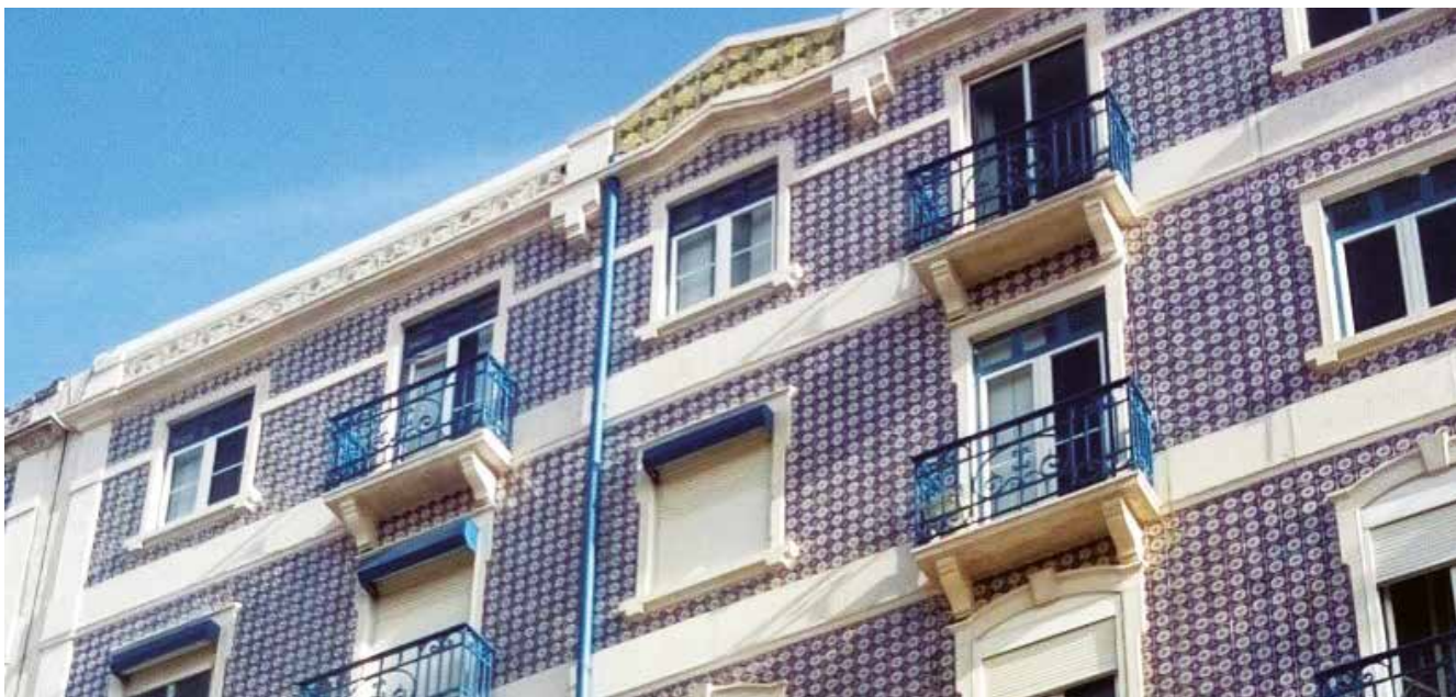
Fig. 10 – Vestígios da galeria sob a varanda, 2019.
