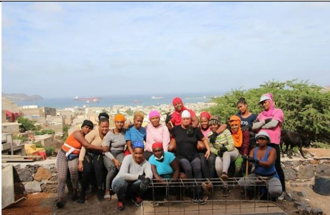
Figura 2 – Construção de um acesso (as obras são sempre realizadas com a participação dos moradores, contribuindo para a construção de comunidade). Fotografia de Grace Ribeiro.
