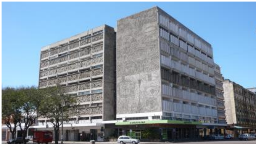
Fig 6. Edifício Abreu Santos e Rocha (1953), Maputo | Pancho Miranda Guedes [Ana Magalhães, 2008]
