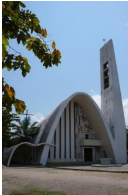
Fig 5. Igreja da Manga (1955-1957), Beira | João Garizo do Carmo [Ana Magalhães, 2008]
