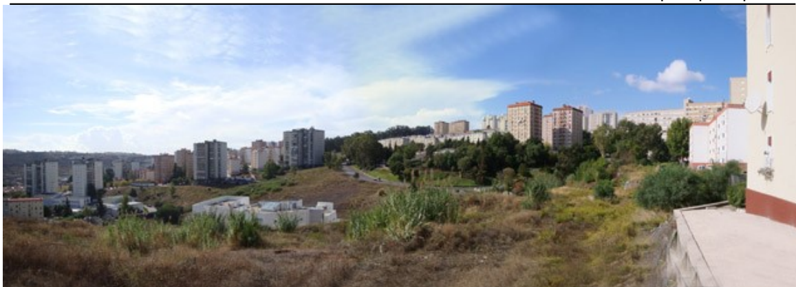
Figura 6 - Terrenos vagos onde se previa a construção dos equipamentos públicos na Urbanização ICESA em Santo António dos Cavaleiros, 2010 (imagem do autor, 2010).
