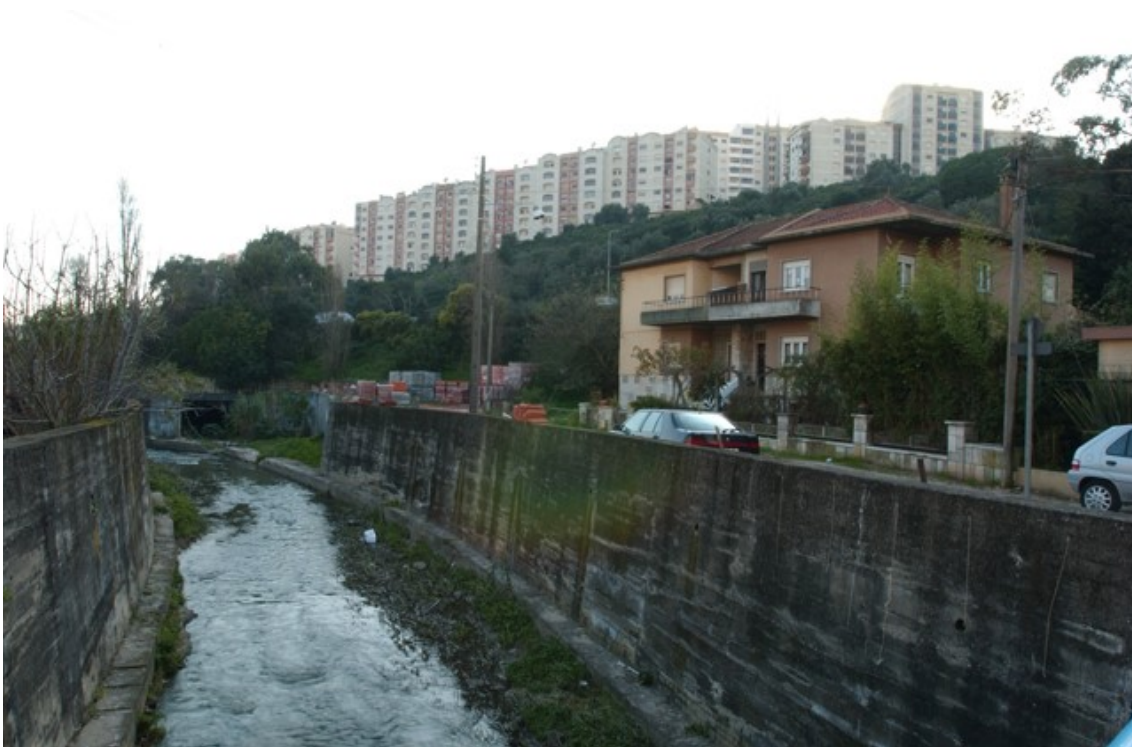
Figura 9 - Ribeira das Jardas antes da intervenção. Fonte: Risco S.A.
