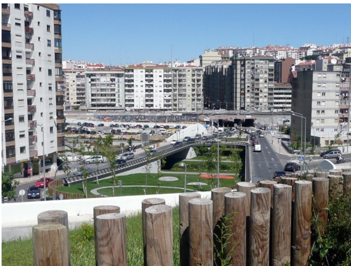
Figura 8 - Vista desde poente da nova rotunda (fotografia do autor)
