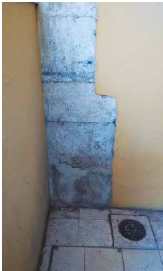
Fig. 13 - Base da coluna visível no alçado interior.
