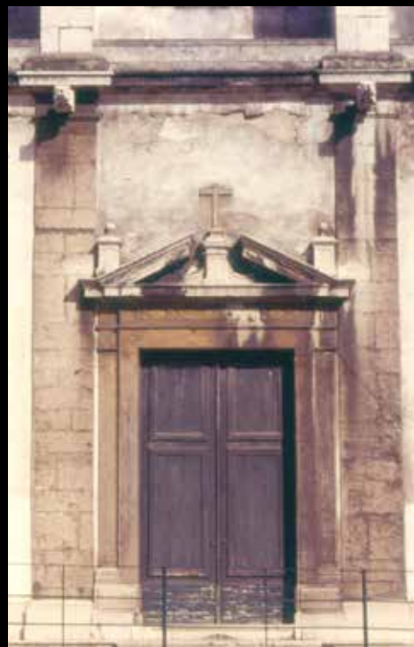
Fig. 2 – Fotografia do Portal da Igreja de Santa Marta, SIPA FOTO.00005922, IPA.00006531.
